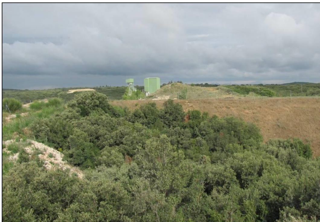
Vue de la carrière et de la zone d'extension
